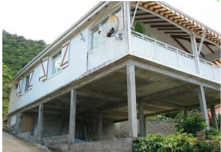
Maison sur piloti « vulnérable » sans dégât.
