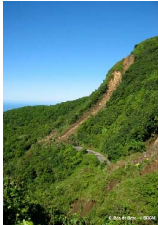
Mouvement de terrain route de la Soufrière
