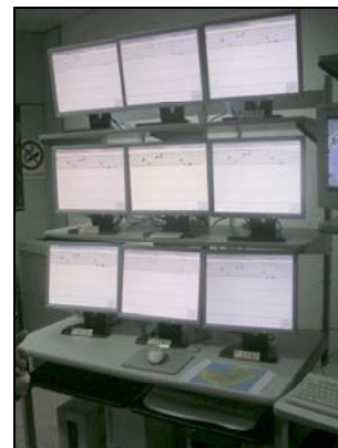
Salle de surveillance sismique à l'OV. Chaque station est affichée en temps réel sur un écran individuel. Le passage du sismographe papier au « tout numérique » n'a ainsi aucun inconvénient en terme de visualisation.
