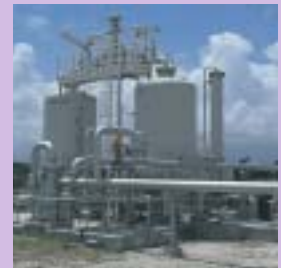
Unité de récupération de vapeurs d'hydrocarbures
