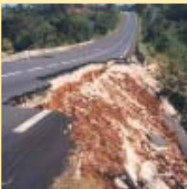
Photographie d'un glissement de terrain sur la route de la traversée durant le cyclone Marylin, 1995
