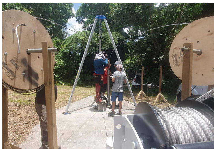
Mise en place des nouvelles stations multi-paramètres en forage (sismomètre, inclinomètre, sonde de pression et température) sur les flancs de La Soufrière de Guadeloupe. Photos réalisées sur le site de Parnasse.
