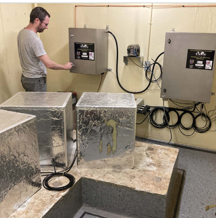
Travaux sur deux stations équipées de capteurs STS-1. A gauche, station UNM (Mexique, juin 2024), à droite, station SPB (Brésil, octobre 2024). A droite, le cache d'un des trois capteurs STS1 a été retiré, rendant le capteur visible/
