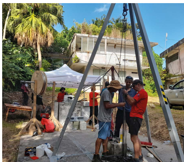
Mise en place des nouvelles stations multi-paramètres en forage (sismomètre, inclinomètre, sonde de pression et température) sur les flancs de La Soufrière de Guadeloupe. Photos réalisées sur le site de Parnasse.
