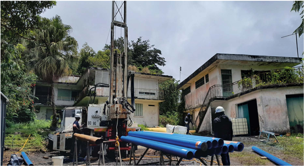
Opération de tubage du forage profond sur le site de l'ancien observatoire de Parnasse à Saint-Claude.
