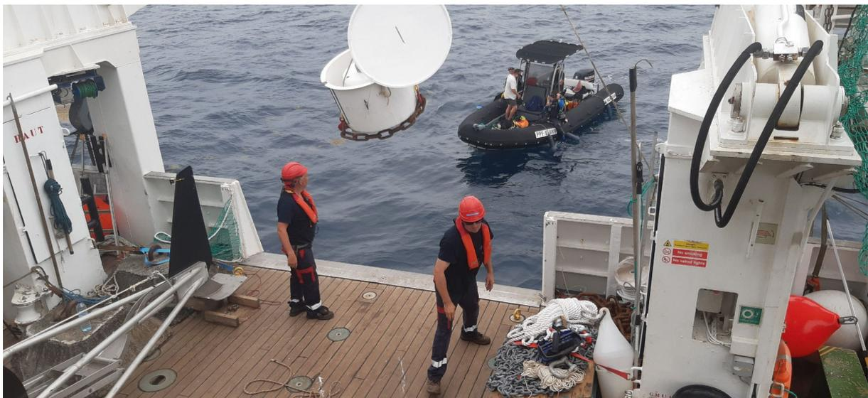
**Figure 51.** Mise à l’eau des touques de l’observatoire sous-marin des Saintes (Guadeloupe) depuis le navire océanographique Antea, avec au second plan les plongeurs dans le zodiac en charge de leur installation.
