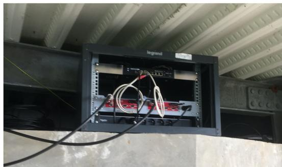
De nouvelles liaisons avec la technologie RIPEX ont été déployées lors de la rénovation des stations sismiques de la Montagne Pelée (**Figure 41**).
