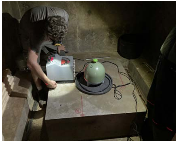
Réinstallation de la station SANVU (Vanuatu) en octobre 2023. Installation du nouveau capteur T360 dans la cave (à gauche) et ajout d'une nouvelle chaîne d'alimentation solaire (à droite).
