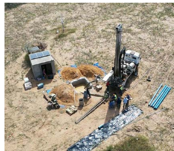
Amélioration des signaux sismologiques à SOK (Sénégal). Vue aérienne du site lors du forage du puits en 2022 (à gauche) et réinstallation du capteur T360 dans le puits de 20 m en juillet 2023 (à droite).
