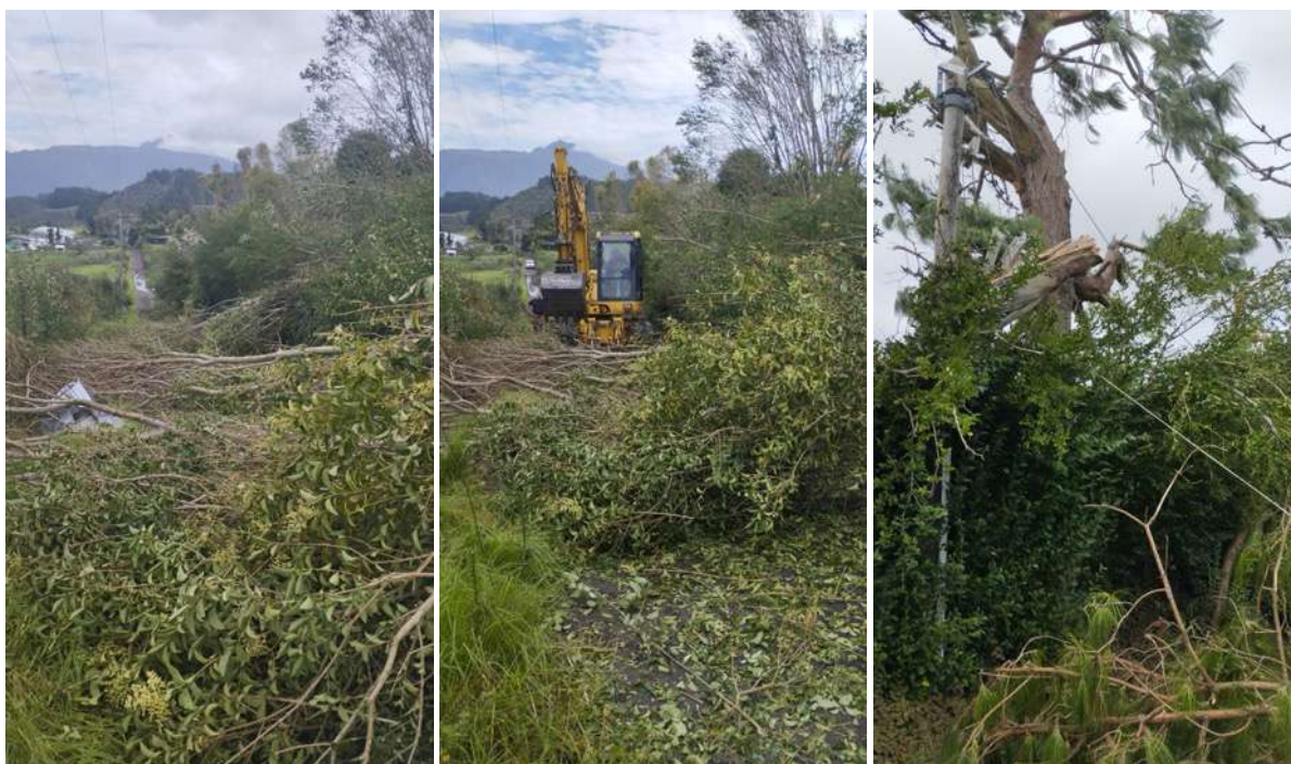
Figure 43 : Photos de l'impasse menant à l'observatoire suite au passage du cyclone Garance (photos du 28 février 2025).
