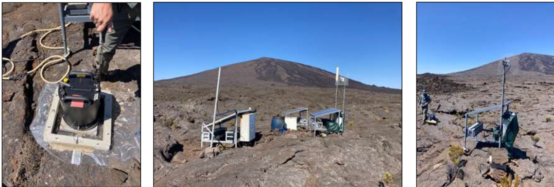
Figure 51 : Installation des équipements du projet BlueSeis. A gauche, le sismomètre rotationnel à la station CSS (Cratère Sery), au milieu de l'infrastructure de la station CSS, à droite une des 7 stations sismiques constituant l'antenne sismique autour de CSS.
