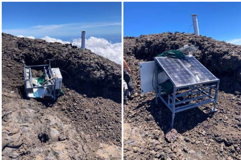
Figure 44 : Station DERG située sur la bordure est du cratère Dolomieu suite au passage du cyclone Garance (photos du 5 mars 2025).
