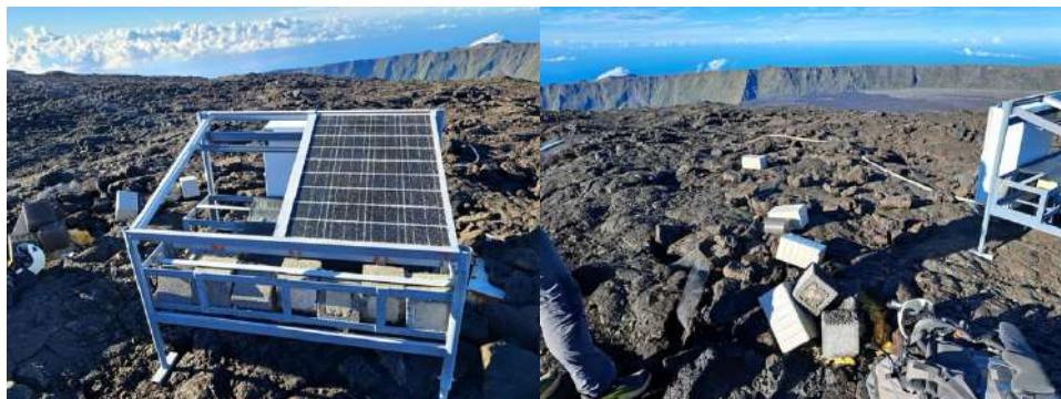
Figure 46 : Station DSOI située sur la bordure sud du cratère Dolomieu suite au passage du cyclone Garance (photos du 5 mars 2025). La station DSO n'est pas visible sur la photo (projeté à plusieurs centaines de mètre dans la pente, difficile d'accès).
