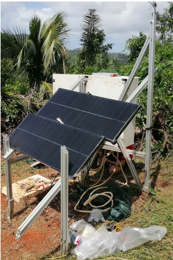
Figure Y2 : Réparation d'une station sismologique détruite par le passage du cyclone Chido.
