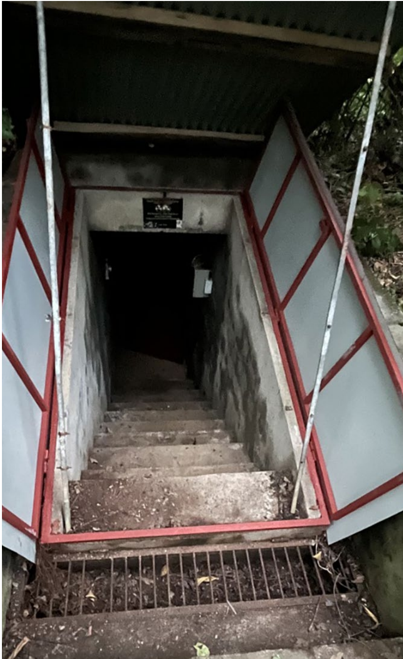
Entrée de la cave sismique à la station FOMA (Madagascar) après sa réfection en juin 2025. Entrance to the seismic vault at station FOMA (Madagascar) after refurbishment in June 2025.
