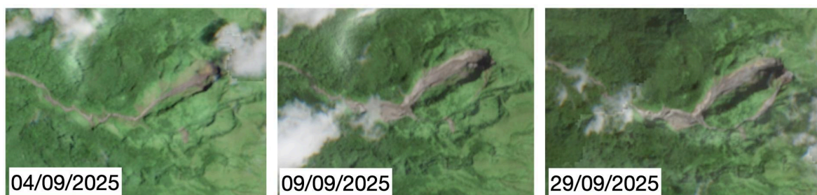
Figure 62 : Images satellitales Sentinel-2 prises le 4 septembre 2025 (avant les phases d'effondrements de flancs importants), le 9 septembre (après la première phase d'effondrements de flanc) et 29 septembre 2025 montrant le recul de la falaise Samperre et l'emprise des zones de dépôts dans les vallées adjacentes.
